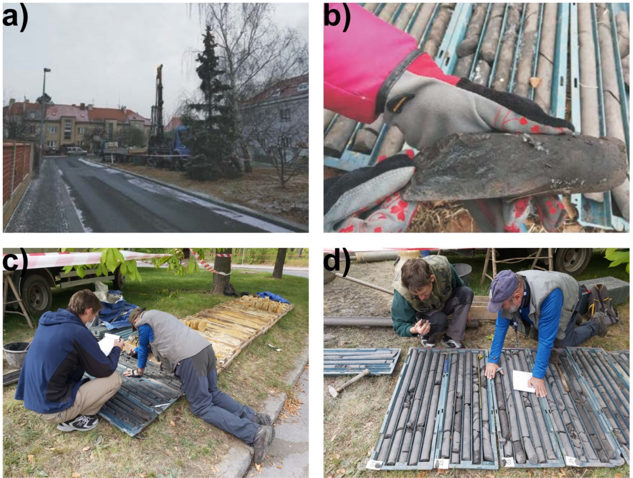
Obr. 2 Dokumentace vrtných prací inženýrskogeologického průzkumu pro trasy železničních tunelů stavby „Modernizace železniční trati Praha-Výstaviště (mimo) – Praha-Veleslavín (mimo)“ v rámci standardního výkonu státní geologické služby: a) Vrtná souprava hloubicí vrt HJ-5; b) Dokumentace jádra vrtu HJ-5; c–d) Dokumentace jádra vrtu HJ-16 (Foto P. Budil leden 2019, M. Aue 24. dubna 2020).
