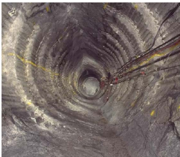
Obr. 22 Testovací tunel v kanadské podzemní laboratoři a schematické znázornění EDZ zón kolem tunelu. Obrázek postihuje porušení v méně běžném případě, kdy větší z hlavních napětí je napětím horizontálním (Read 2004).
