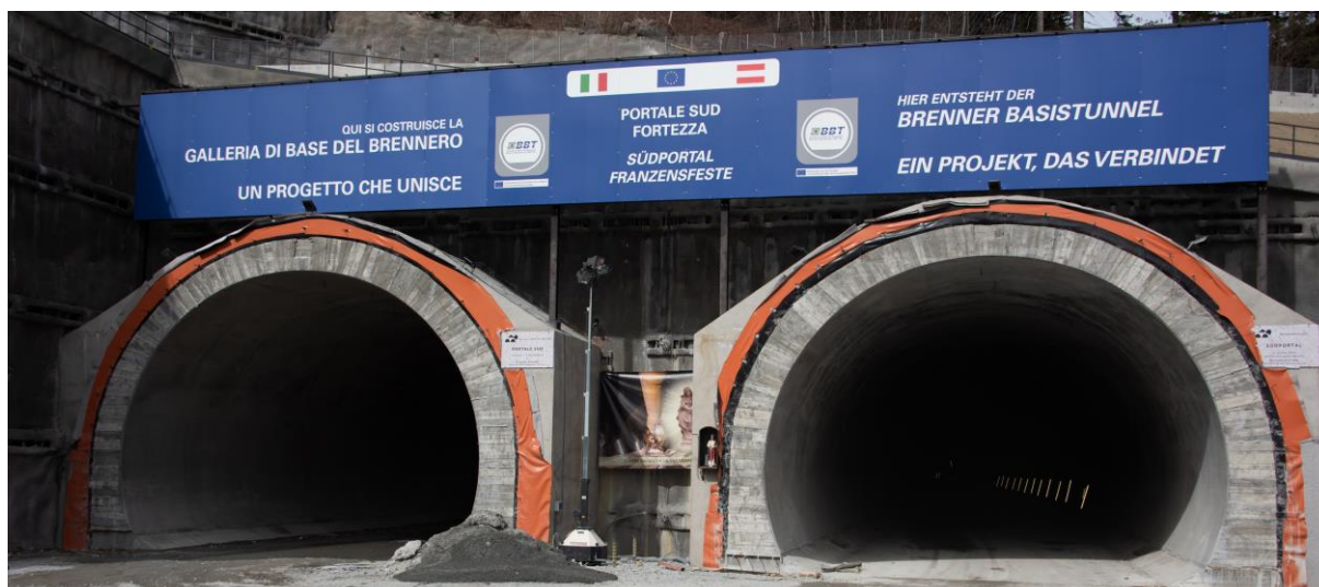
Obrázek č. 6: Jižní portál Brennerského tunelu Zdroj: bbt-se.com
