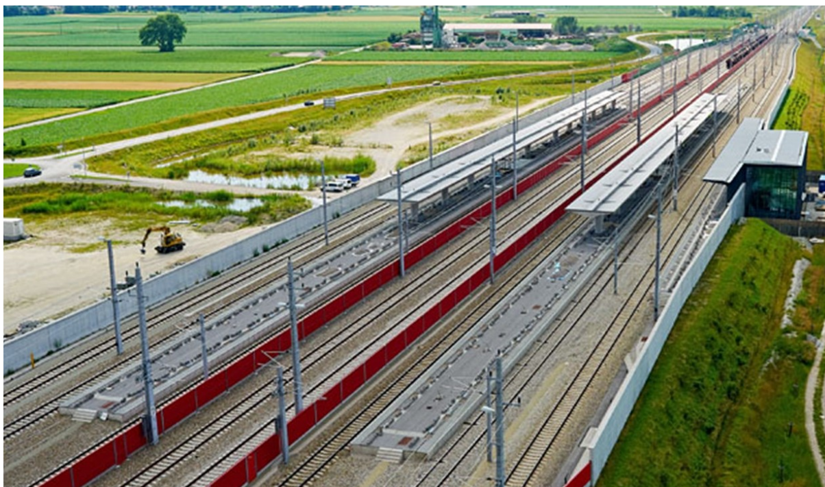
Obrázek č. 7: Čtyřkolejné dráhy zvyšují propustnou výkonost koridorů Zdroj: ÖBB
