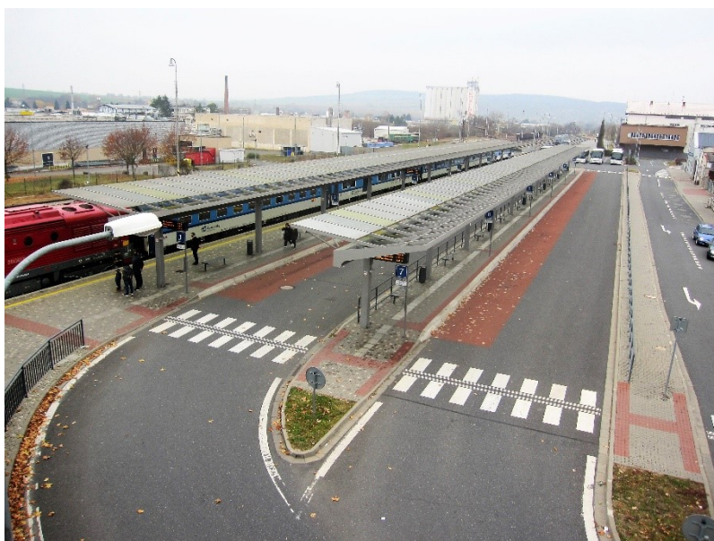
Obr. 8: Uherský Brod, pohled z lávky na přístup k nástupištím, (zdroj: Ing. J. Kavan)
