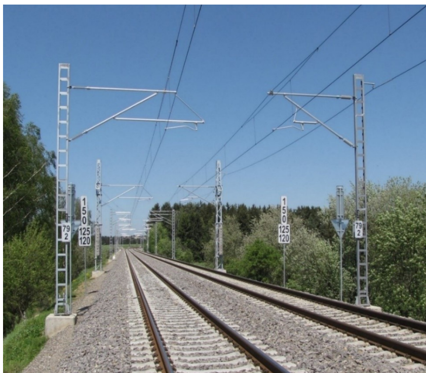
Obrázek 1: Návěšt traťová rychlost pro jednotlivé druhy vozidel
