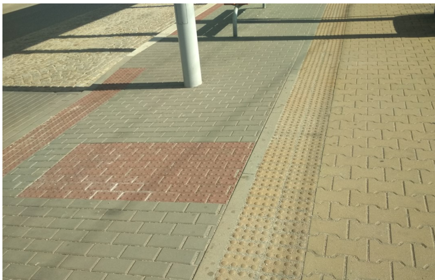
Obr. 10 Břeclav, napojení SP od místa pro přecházení ke středové linii nástupiště, (zdroj: Jan Stöhr)
