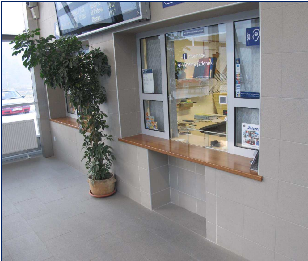
Obrázek 15 - Správné provedení bezbariérové přepážky.
