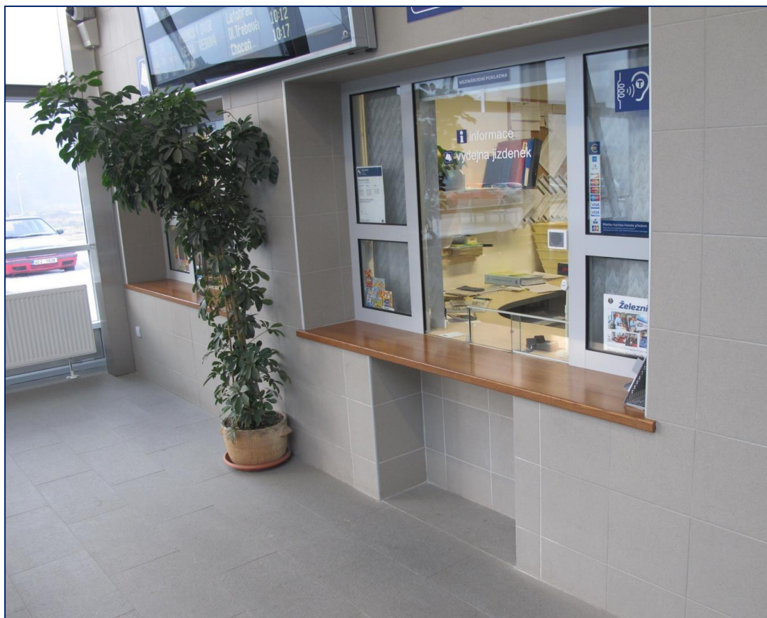
Obr. 14: Správné provedení bezbariérové přepážky
