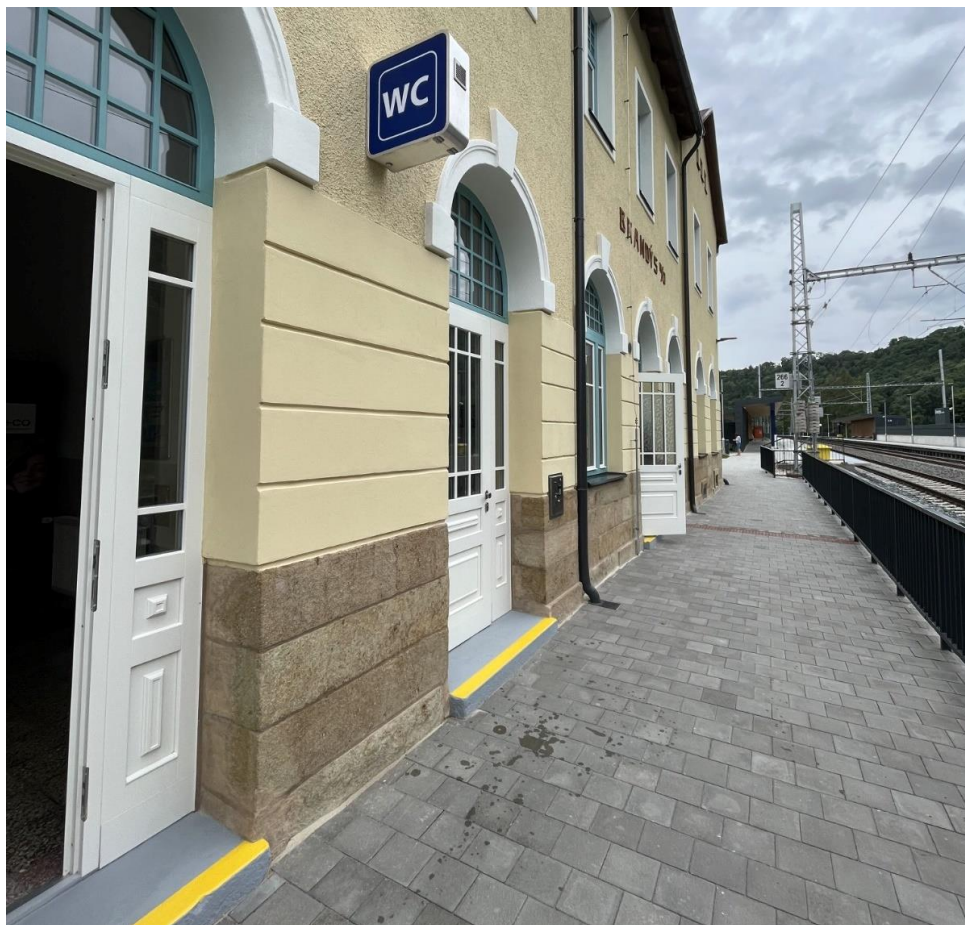
Obr. 7: výsledek změny projektu, která neprošla ani interní kontrolou. Na rozhraní zůstal nyní nadbytečný varovný pás a bezbariérové WC je přístupné přes vyrovnávací stupeň.
