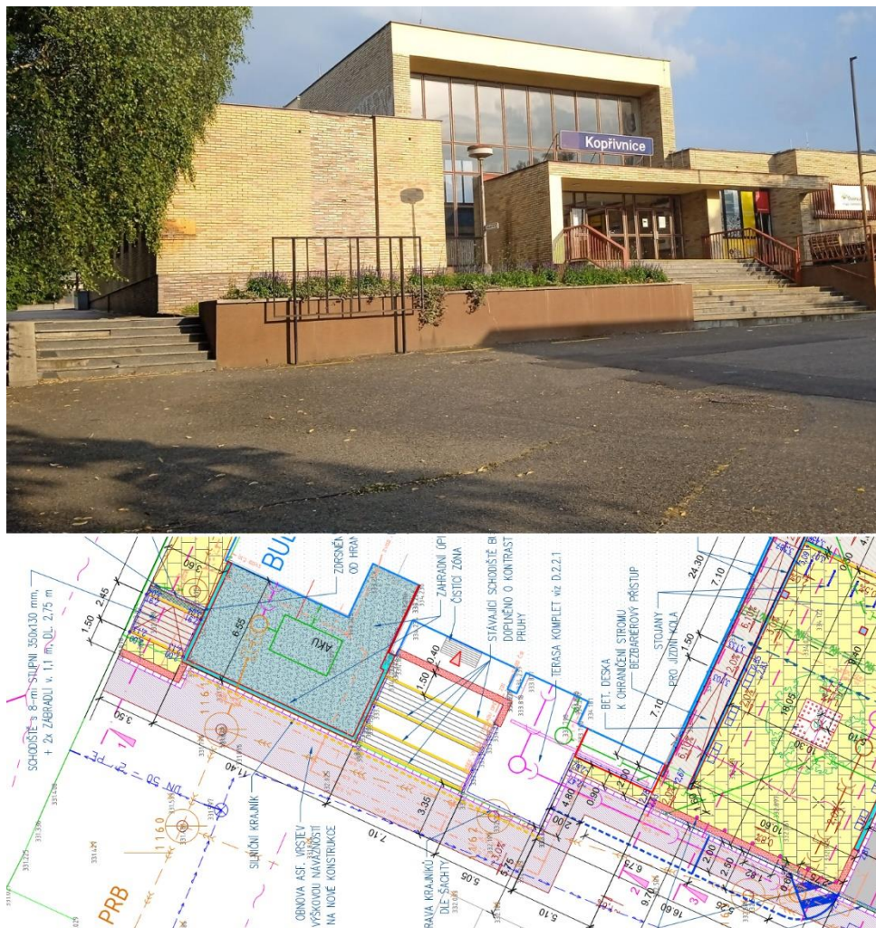
Obr. 2: žst. Koprivnice nemá jediný bezbariérový přístup z okolí. Ani rozsáhlá rekonstrukce tento problém neřeší, neboť stavba končí varovnými pásy pod a nad schodištěm na hranici drážního pozemku.
