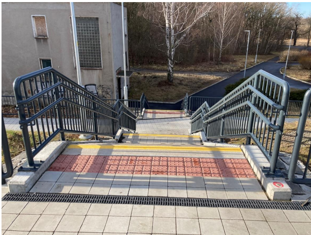
Obr. 8: nevhodnou dlažbou zde namísto zdrsňeného pásu vznikl pás varovný, zastávka Duchcov
