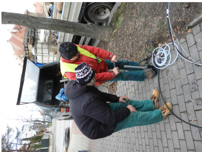
uchycování snímače v pozici pomocí pneumatického natlakování (neotáčeno)
