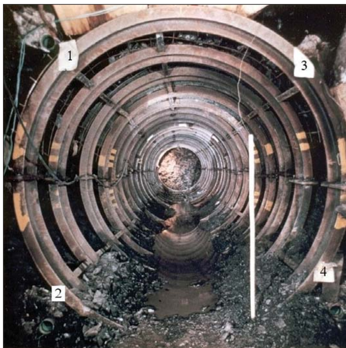
Obr. 4 Celkový pohled do odlehčovací štoly po vyražení délky 10,3 m Fig. 4 Overall view down the stress-relief gallery after the completion of the excavated length of 10.3m
