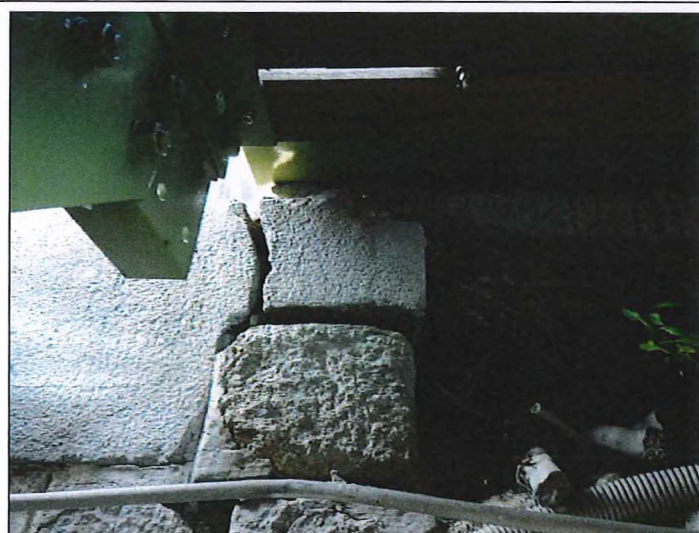
Obr. č. 14 – Opěra O 02 – závěrná zed' vpravo – uvolněné 2 kameny
