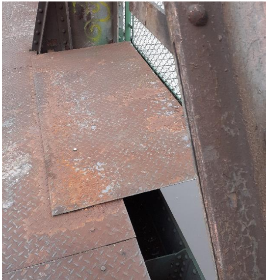
Překrytí dolního pásu v místě výklenku (pravá strana K02)
