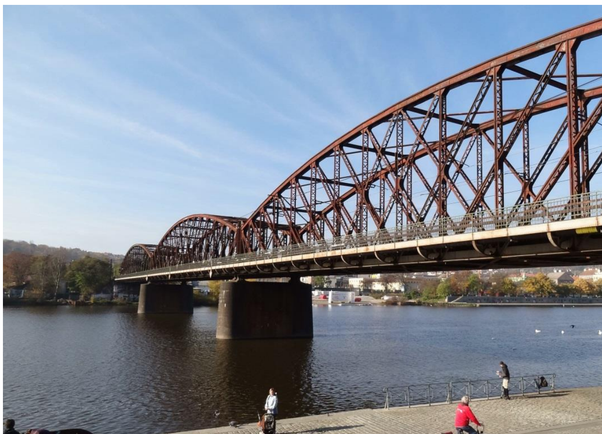
Severní pohled po proudu řeky Vltavy na most v km 3,706 trati Praha hl. nádraží - Smíchov
