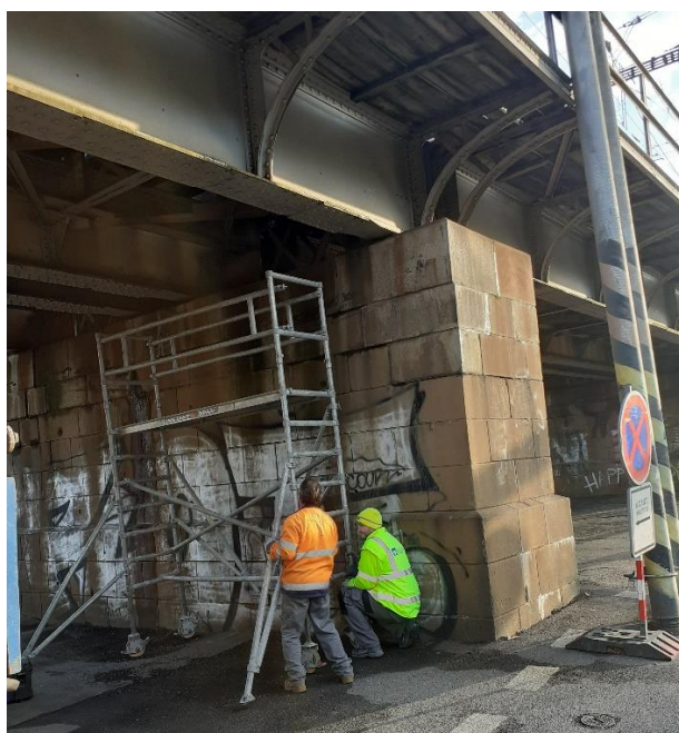
Most v ev. km 3,545 (K05 a K03) pohled směr Vyšehrad
