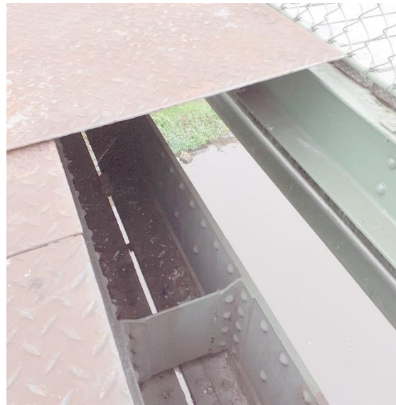
Překrytí dolního pásu v místě výklenku (pravá strana K02)
