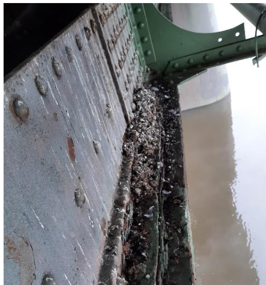
Nánosy holubího trusu na dolního pásu v místě výklenku (pravá strana K02)
