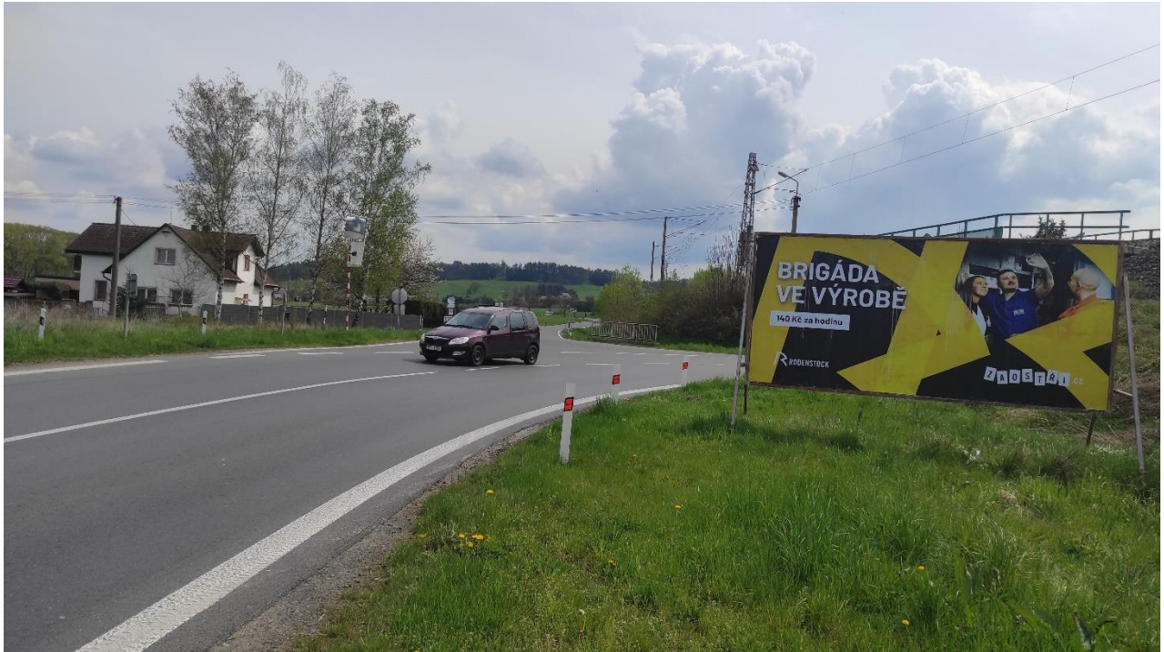
Příloha č. 1: Fotodokumentace odstraněného a zlikvidovaného reklamního zařízení
