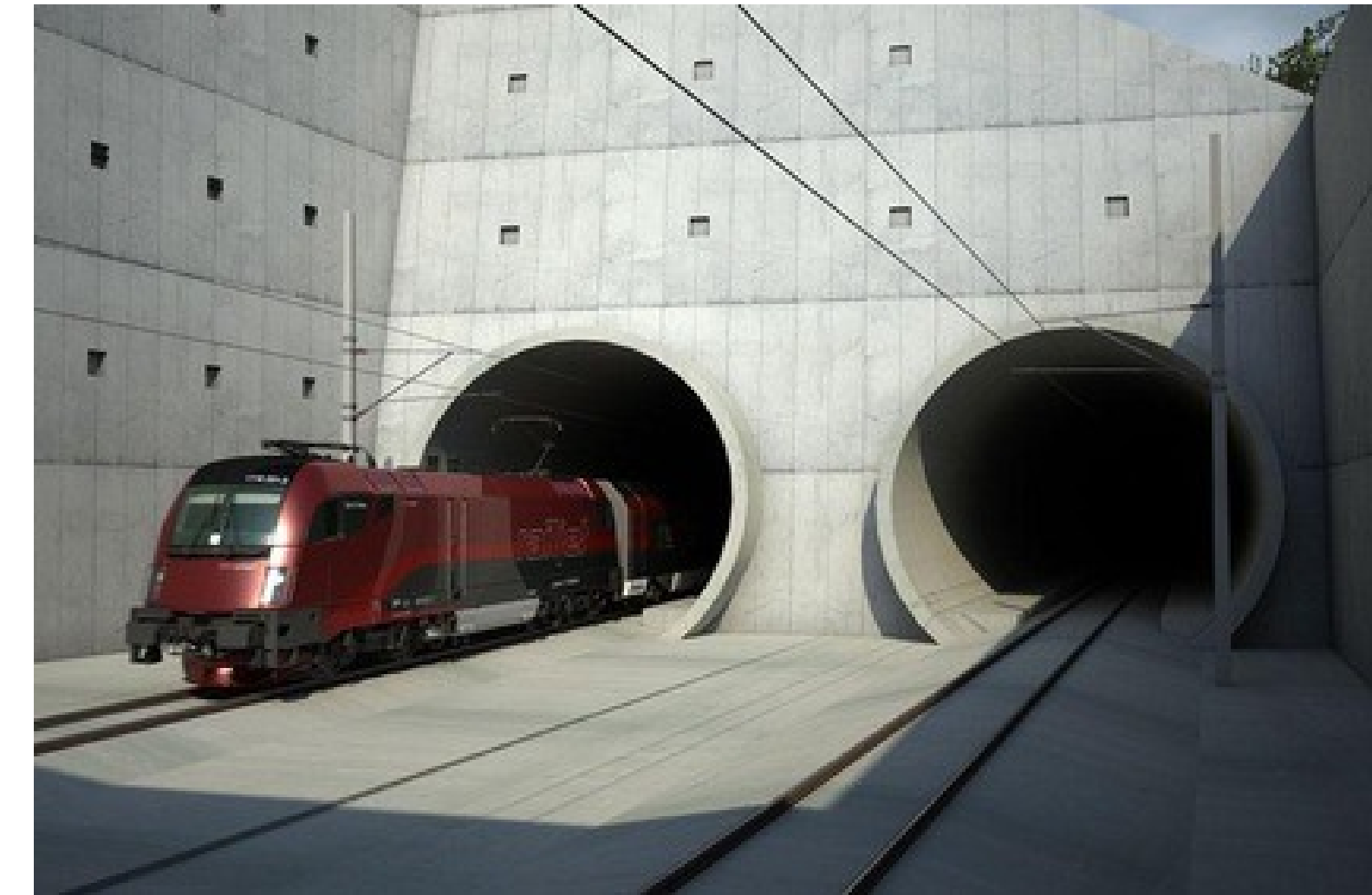
Vlevo staveniště tunelu s protihlukovou zdí v rakouském Semmeringu, vpravo tunelový portál v Mürzzuschlagu
