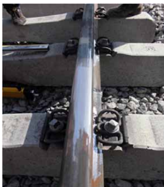
Obr. 7 - 9: Provedené svary před a po obroušení [2]
