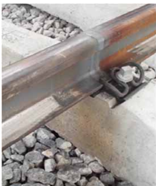
Obr. 7 - 9: Provedené svary před a po obroušení [2]
