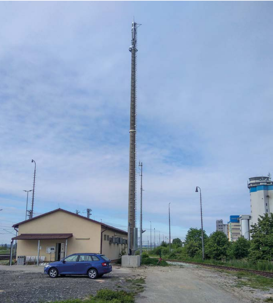
Stožár základnové stanice v Dyně
