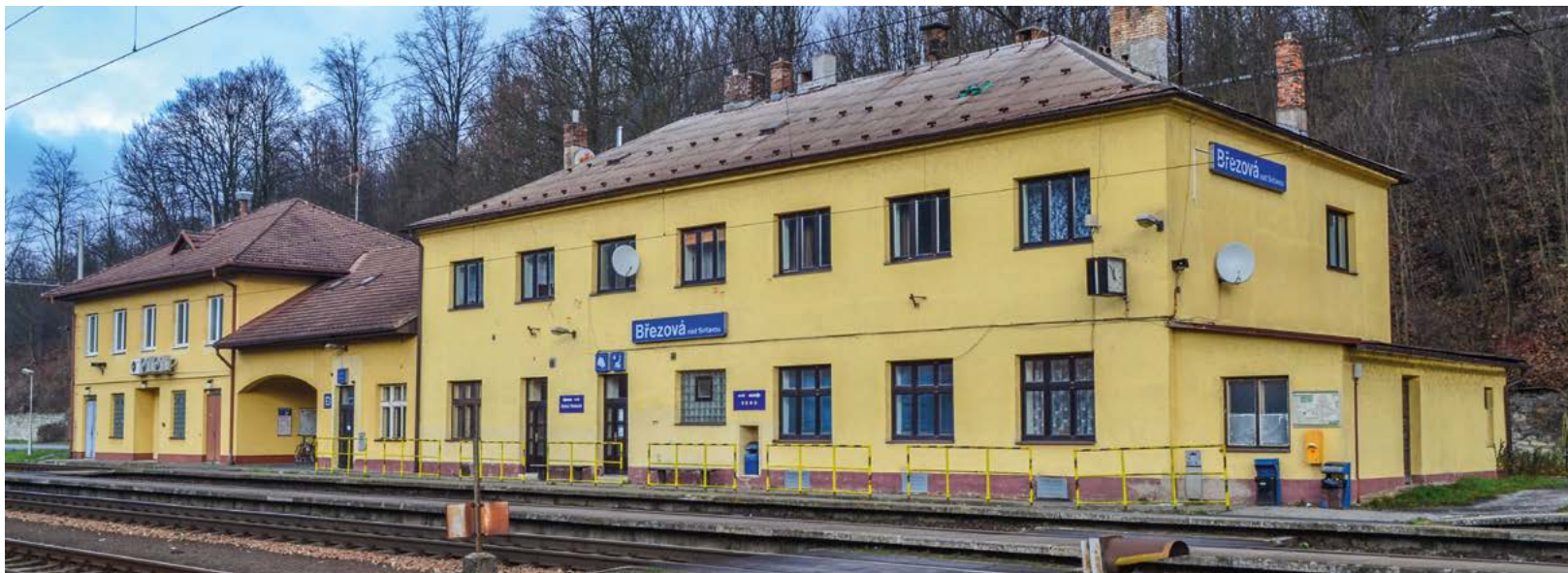
Stávající stav stanice Březová nad Svitavou
