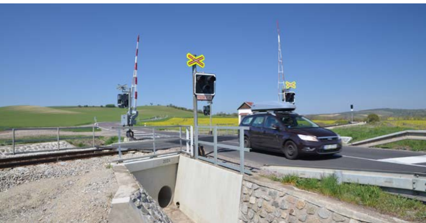
Rekonstruovaný železniční přejezd na trati Břeclav–Znojmo
