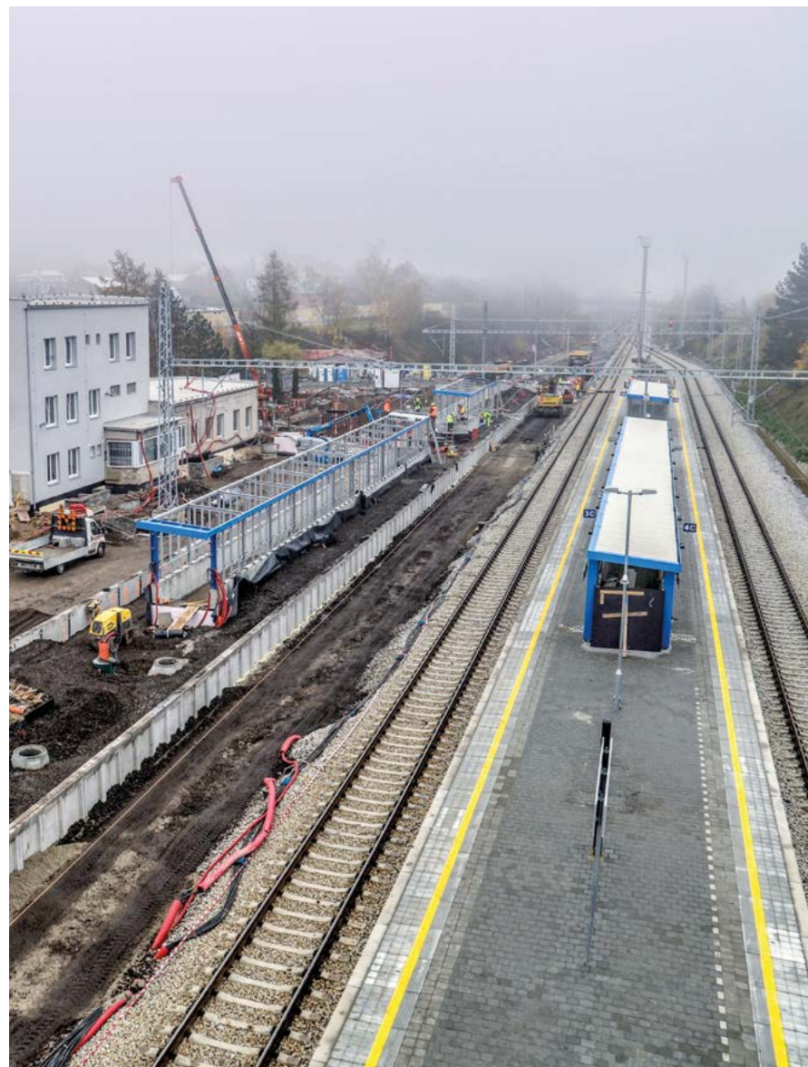
Rekonstrukce traťového úseku Křižanov – Sklené nad Oslavou (mimo)
