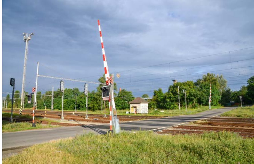
Železniční přejezd P8155 v km 111,535 trati Břeclav–Přerov bude v budoucnu zrušen
